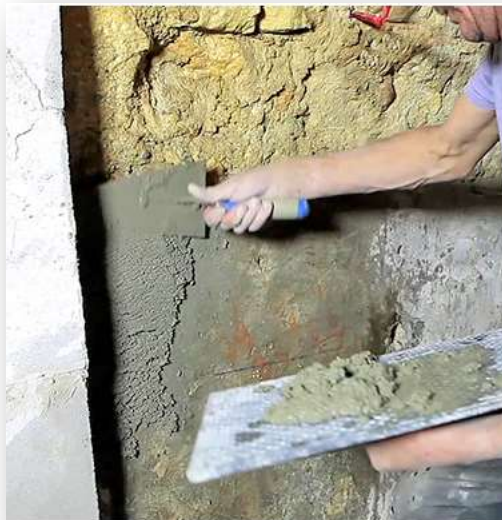
Figure 32 : Rebouchage de l'ensemble des fissures et anfractuosités des murs en pierre.
