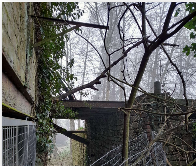
Figure 16 : Plancher entre le bâtiment principal et la zone 2.
